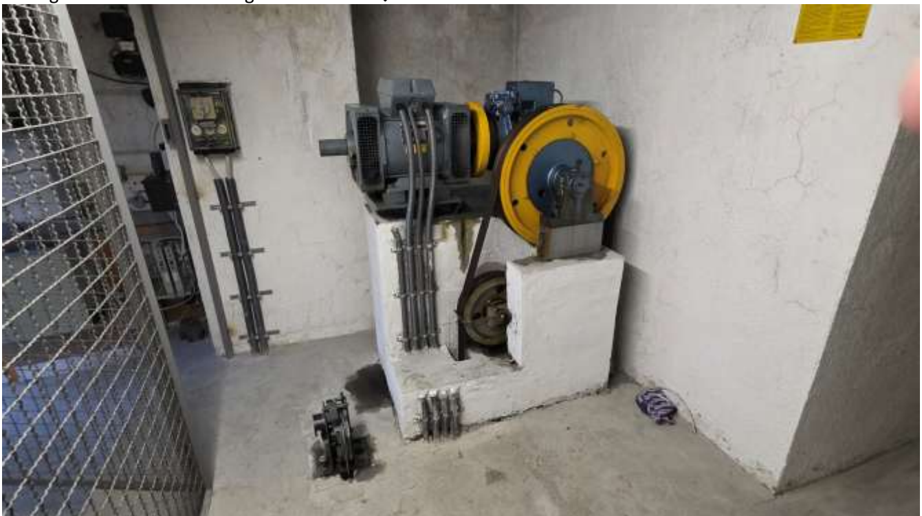
Aufzugsantriebseinheit Ludwig-Braille-Str. 10 ↓
