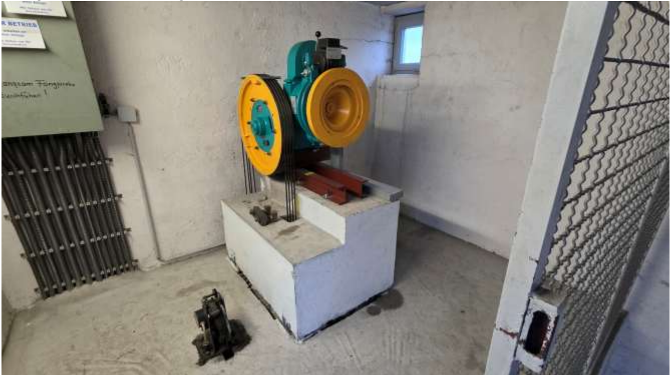
Aufzugsantriebseinheit Ludwig-Braille-Str. 8 ↓
